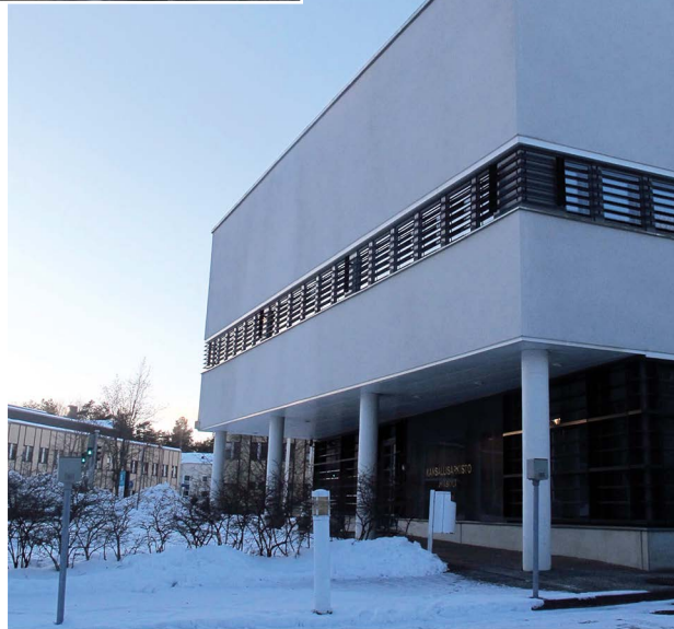
Kansallisarkiston Jyväskylän toimipaikan vuonna 2000 käyttöön otettu uudisrakennus, josta tutkijat vielä pitkään käyttänevät sen alkuperäistä nimitystä Jyväskylän maakunta-arkisto.
